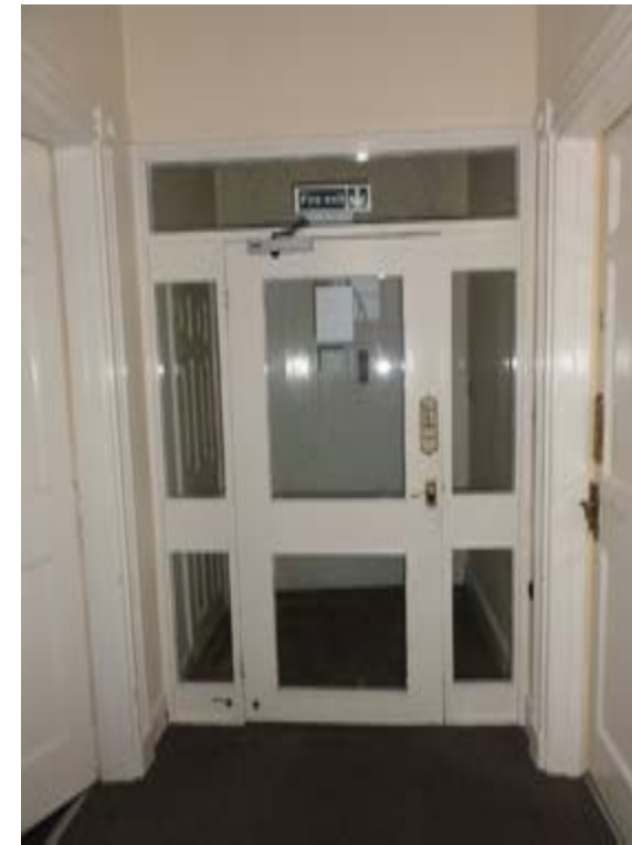
Photo182 – G03 - Ha11 1 - Door DG3
