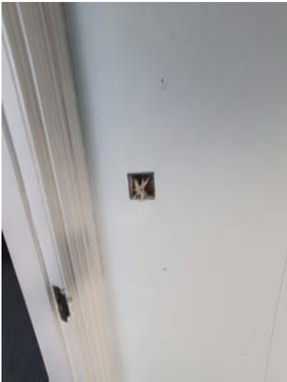
Photo224 – G04a - Lobby - Door DG17
