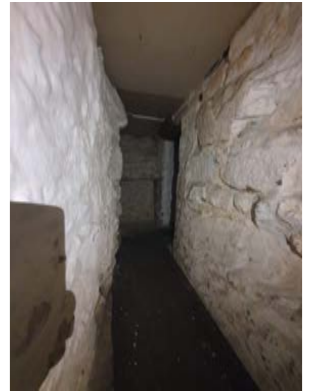
Photo032 – B03 - Basement Room 1
