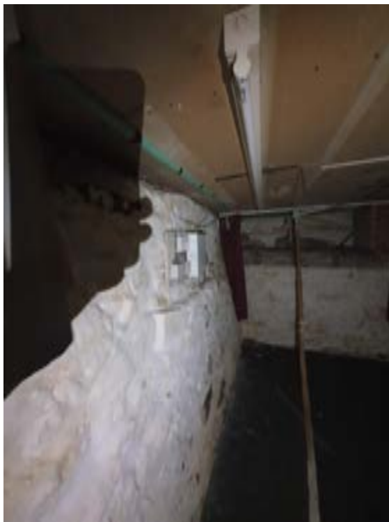
Photo034 – B03 - Basement Room 1
