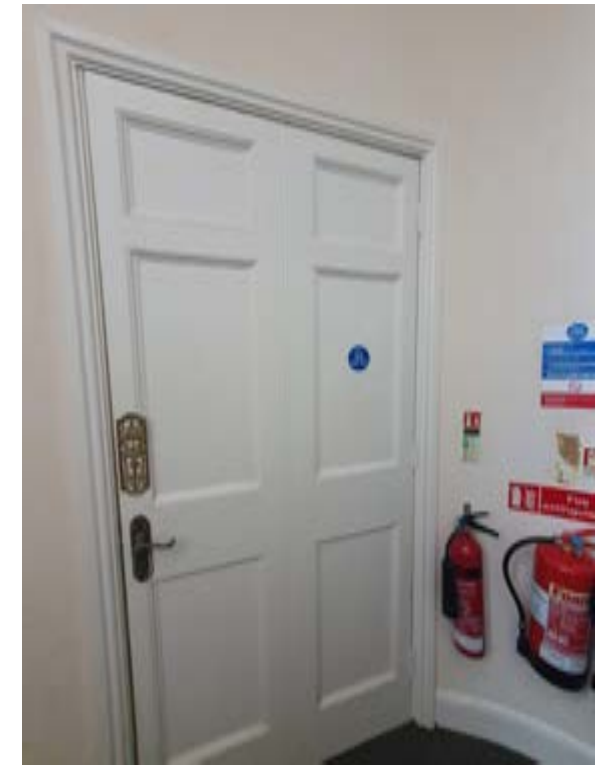
Photo160 – G03 - Ha11 1 - Door DG20 ( Door to be removed)
