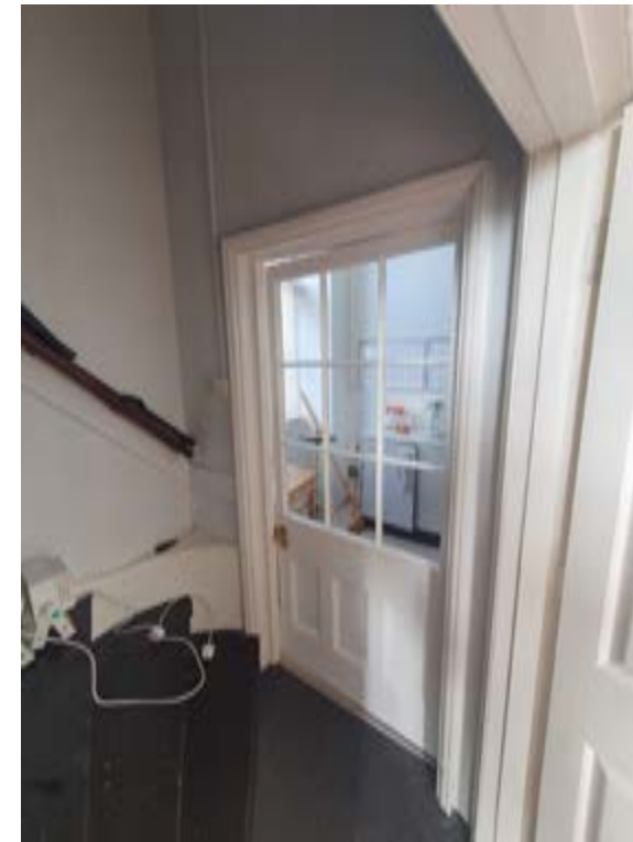
Photo334 – F04 - Balcony Stair - Door DF3
