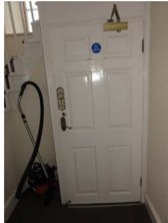
Photo180 – G03 - Ha11 1 - Door DG10
