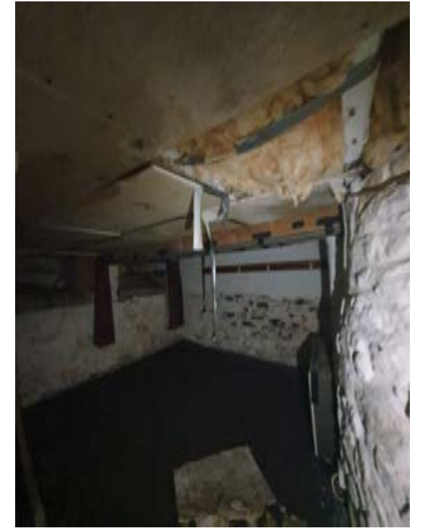
Photo039 – B03 - Basement Room 1
