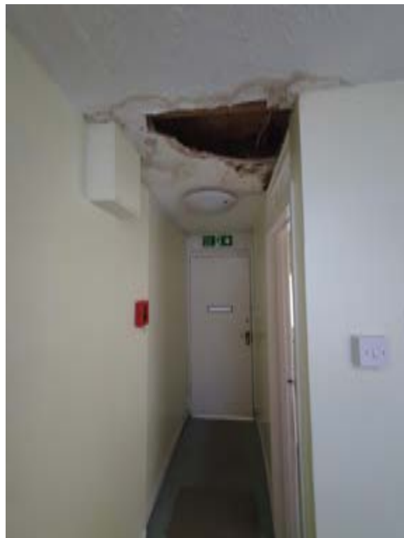
Photo268 – G07 - Kitchen 1 - Door Dg11
