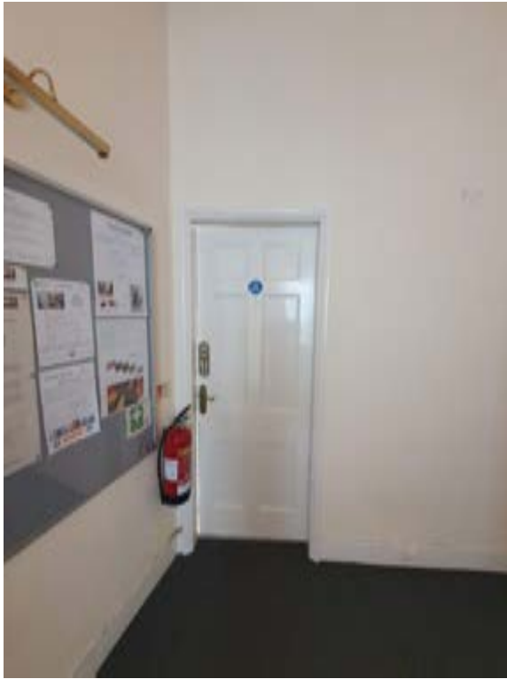
Photo305 – F01 - Landing - Door DF4
