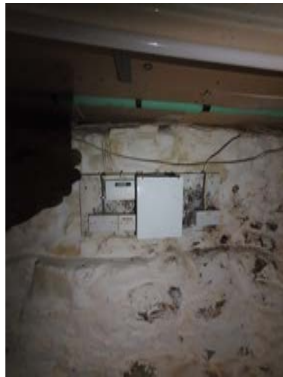
Photo036 – B03 - Basement Room 1
