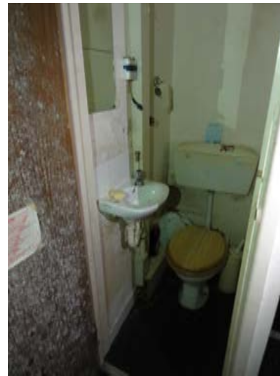
Photo110 – B06 - Basement WC - Door DB1
