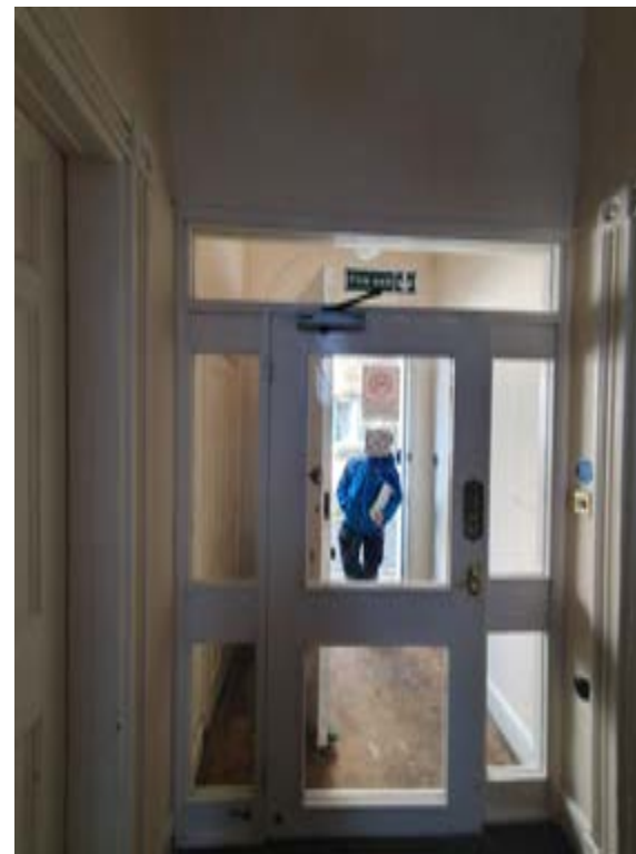
Photo166 – G03 - Ha11 1 - Door DG3
