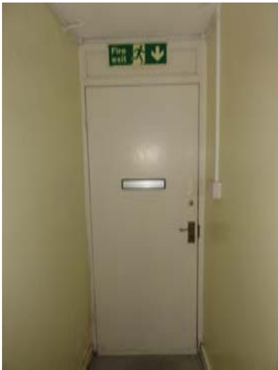
Photo274 – G07 - Kitchen 1 - Door DG11
