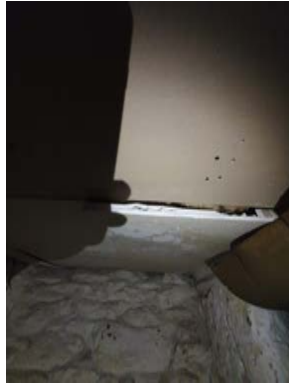
Photo035 – B03 - Basement Room 1
