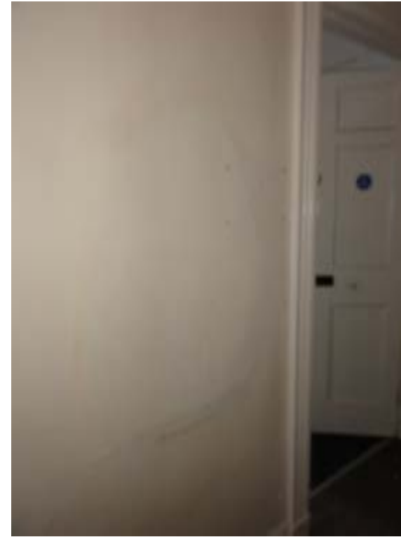
Photo197 – G03 - Ha11 1 - Door DG6
