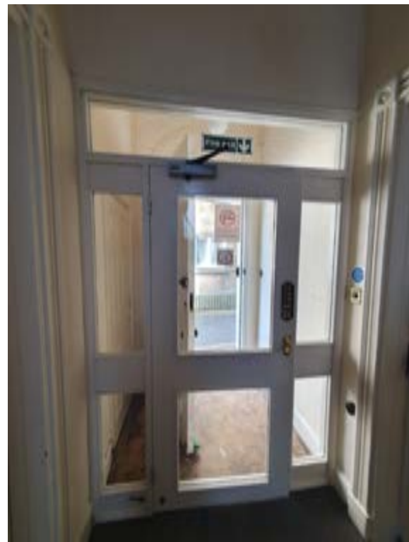
Photo164 – G03 - Ha11 1 - Door DG3
