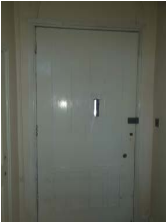
Photo138 – G02 - Entry - Door DG1
