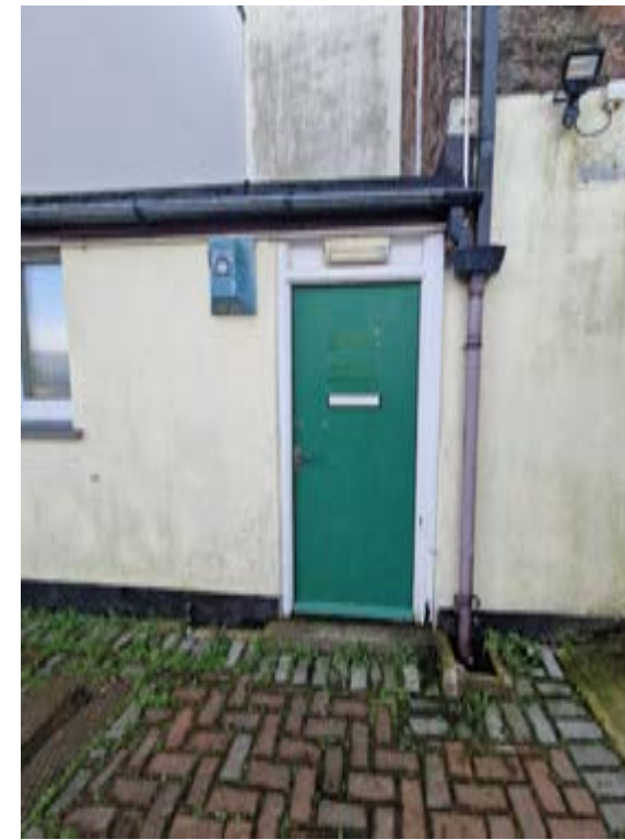
Photo357 – External - Door DG11
