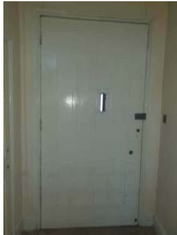
Photo140 – G02 - Entry - Door DG1
