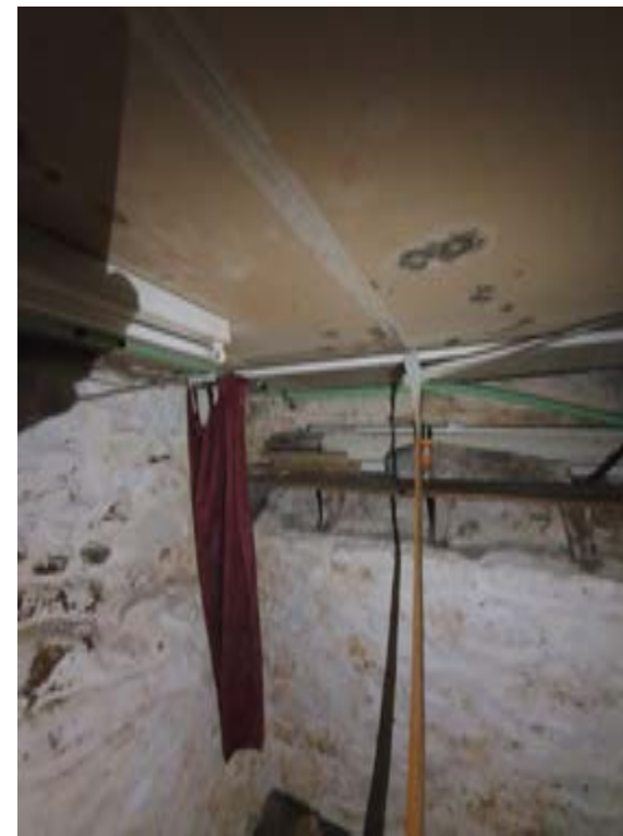
Photo038 – B03 - Basement Room 1
