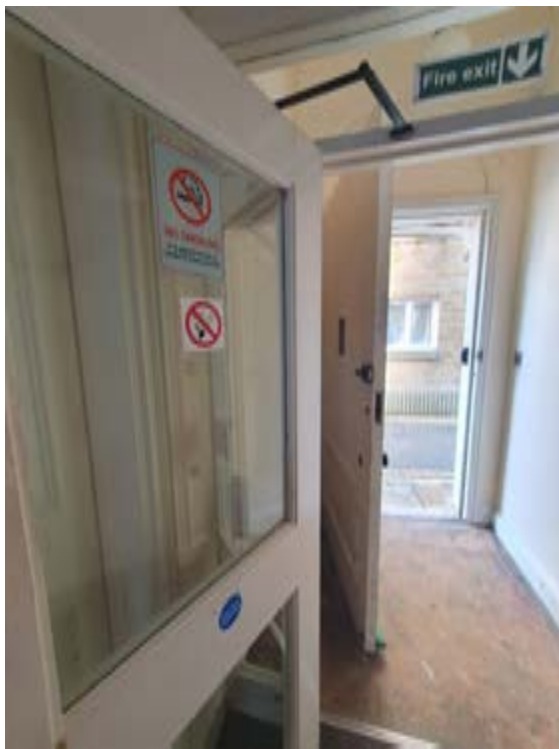
Photo162 – G03 - Ha11 1 - Door DG3
