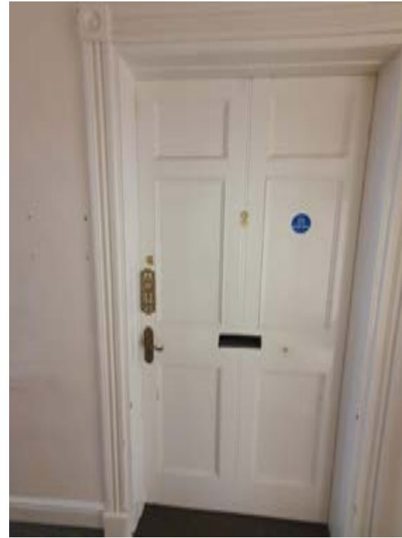
Photo165 – G03 - Ha11 1 - Door DG6
