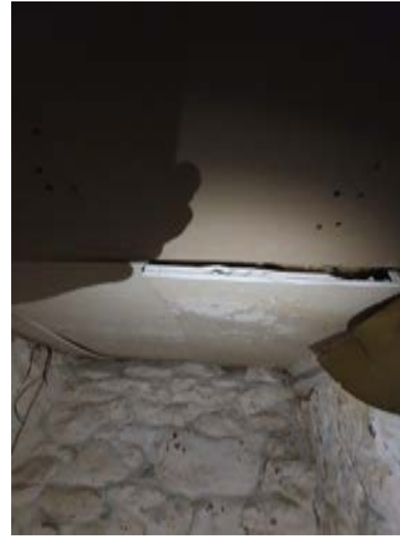
Photo037 – B03 - Basement Room 1
