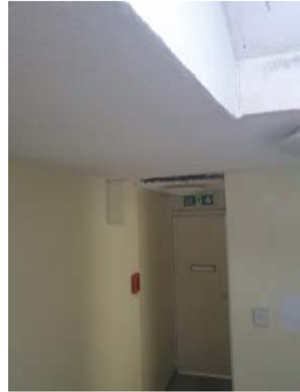
Photo279 – G07 - Kitchen 1 - Door DG11
