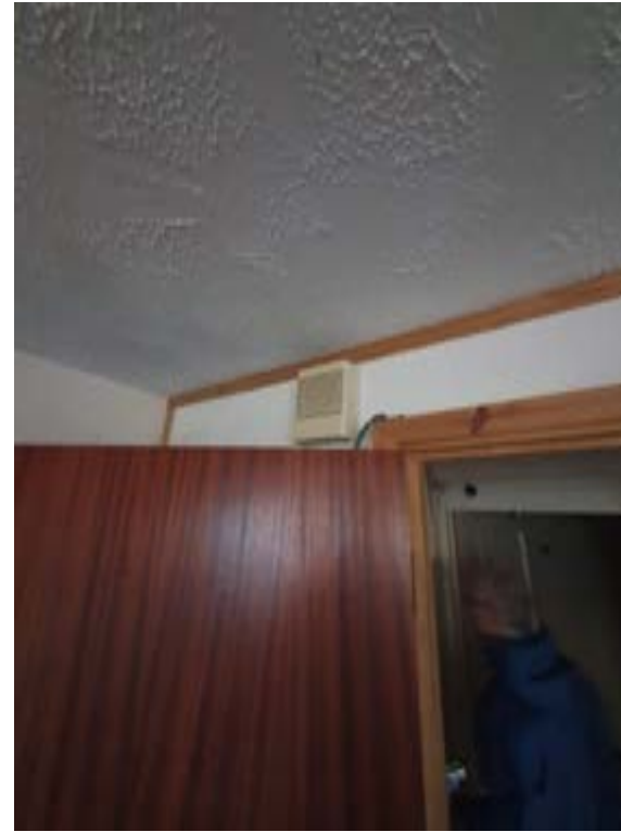
Photo085 – B04 - Basement Room 2 - Door DB4
