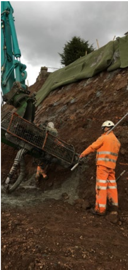
A465 HoTV DYWI® Drill Hollow Bar & DYWI® Mat Green
