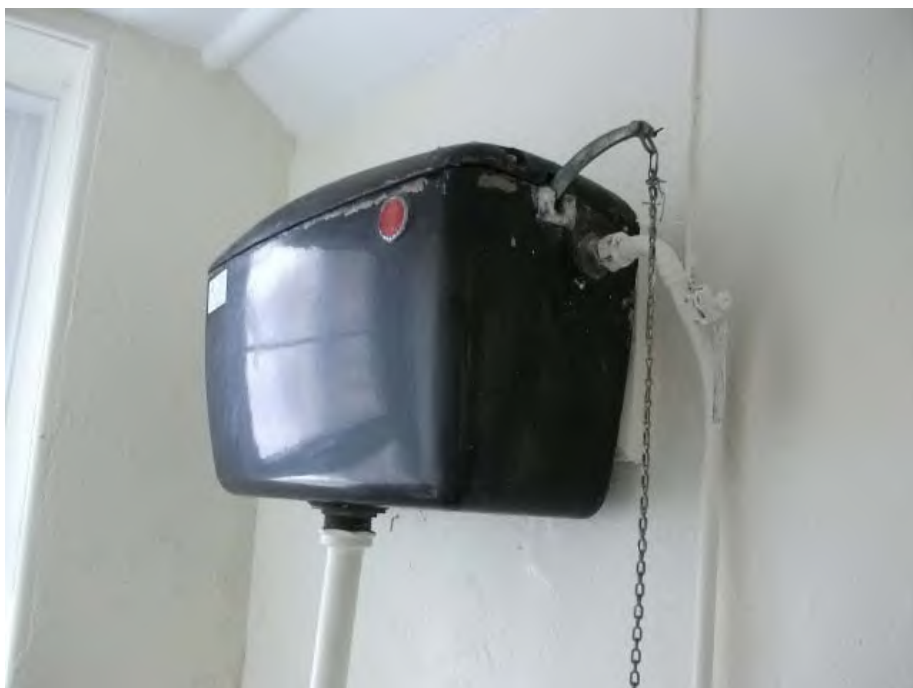
Photo 4: 0/038 Toilet – Asbestos toilet cistern
